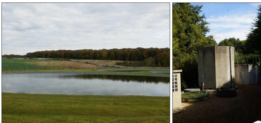
Les bassins de lagunage à Maillebois (à g.) et la station d'épuration de Dampierre-sur-Blévy (à d.)
