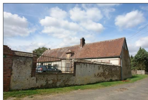
Un muret de clôture (hameau des Châtelets)
